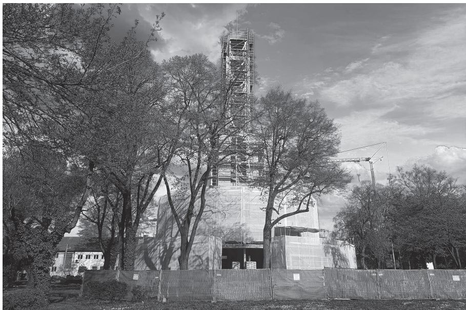
Renovierungsarbeiten am Turm der ehemaligen Lagerverwaltung. Foto der Autorin
